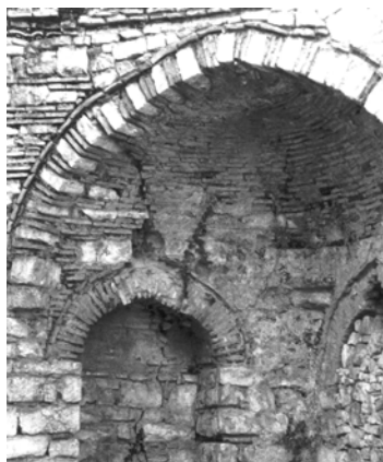
Φωτογραφίες 2α, 2β. Βλάβες σε θόλους και καμάρες. Pictures 2a, 2b. Damages at domes and arches.
