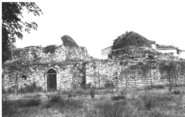
Φωτογραφίες 1α, 1β. Το Χαμάμ Ιωαννίνων πριν και μετά την κατάρρευση του θόλου του ψυχρού χώρου. Pictures 1a, 1b. The Ottoman Bath before and after the collapse of the dome of the cool chamber.
