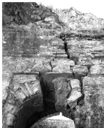
Φωτογραφίες 2α, 2β. Βλάβες σε θόλους και καμάρες. Pictures 2a, 2b. Damages at domes and arches.
