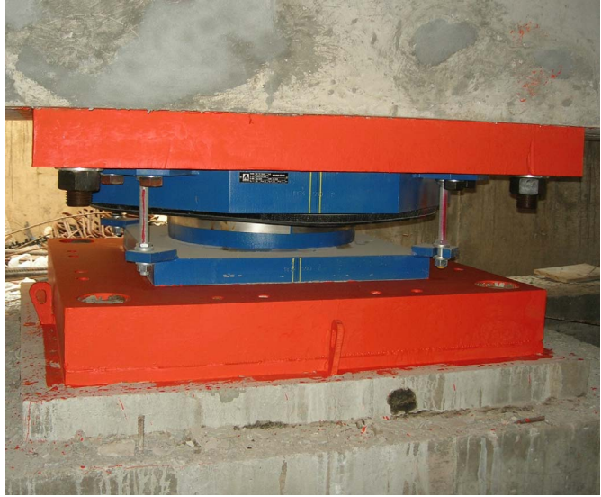
Σχήματα 1, 2. Διγραμμικό μοντέλο εφεδράνου ολίσθησης (FPS) και τοποθετημένο εφέδρανο.
